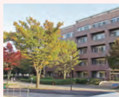
3 1号館 (大学教育・学生支援機構(学生センター))
