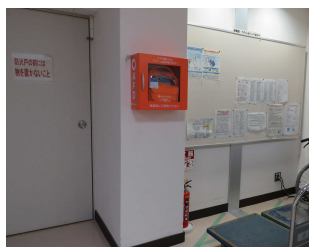
⑥：1号館 1階玄関ホール内
