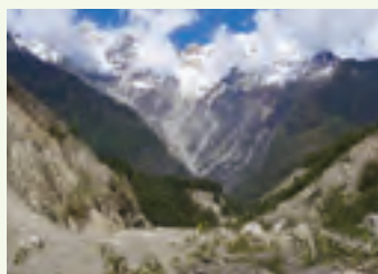
チベットに発生した巨大地すべり
